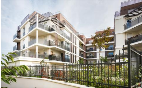
FONTENAY-LE-FLEURY (78) Le Bel Canto 27 logements Livraison S2 2016
