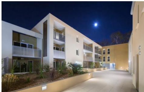
SAINT-JEAN-DE-VEDAS (34) Océanis 22 logements Livraison S2 2017
