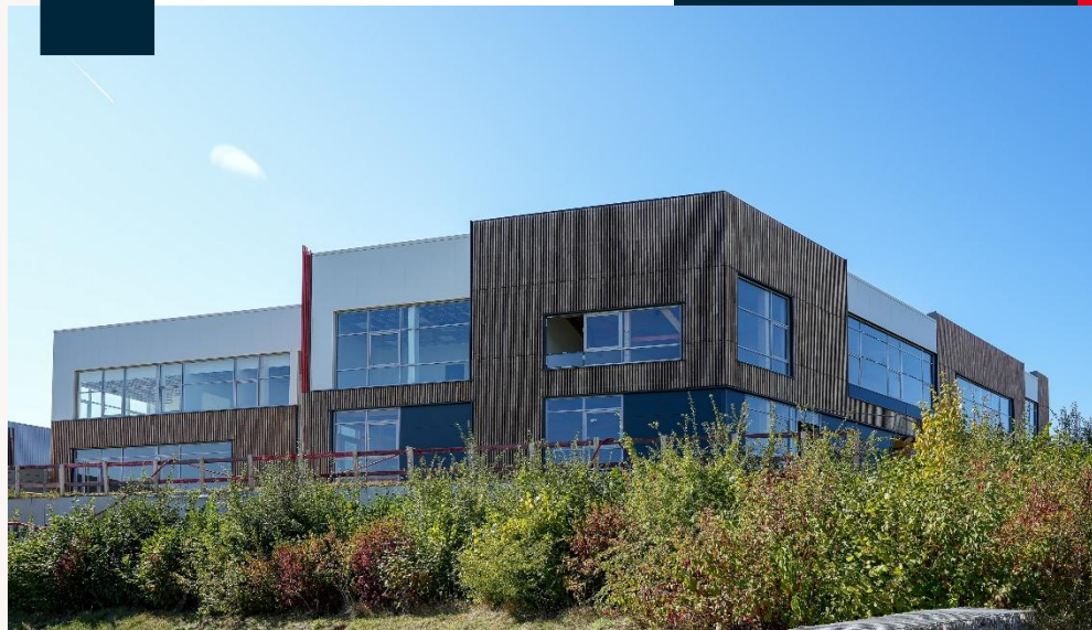
Parc Spirit Louvres 2 Louvres (95)
