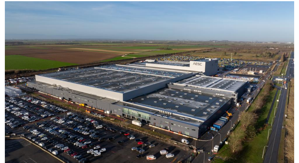
Gigafactory de batteries AESC, à Douai (59) – source : Vinci Construction
